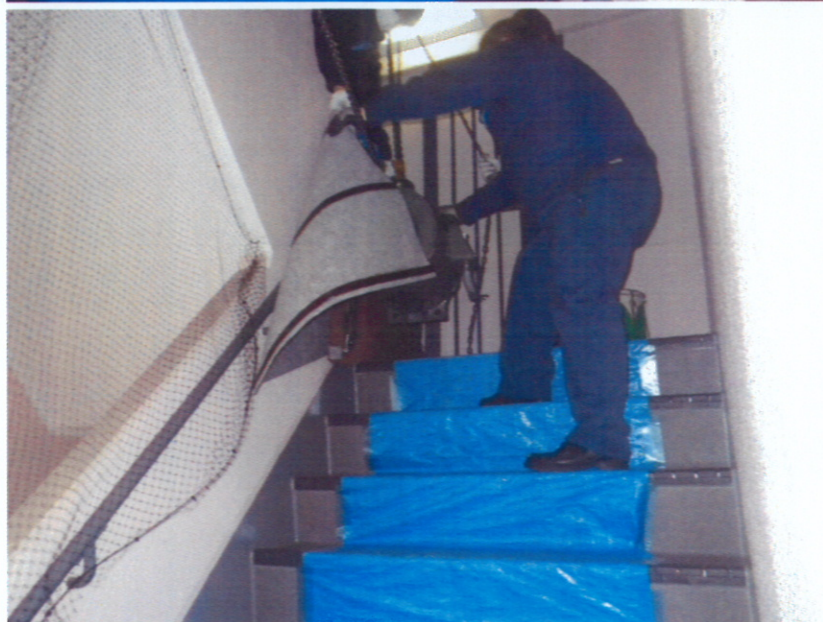
東棟 施工中 部材搬出③
