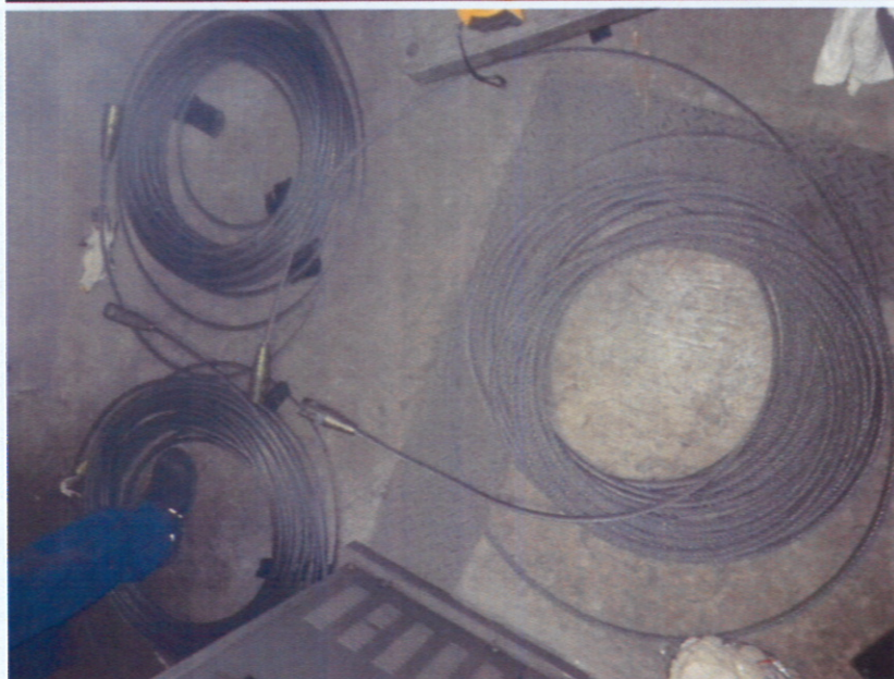
東棟 施工中 主ワイヤーロ ープ取替①
