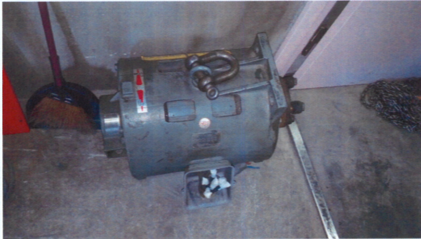
西棟 施工中 巻上モーター 撤去品①
