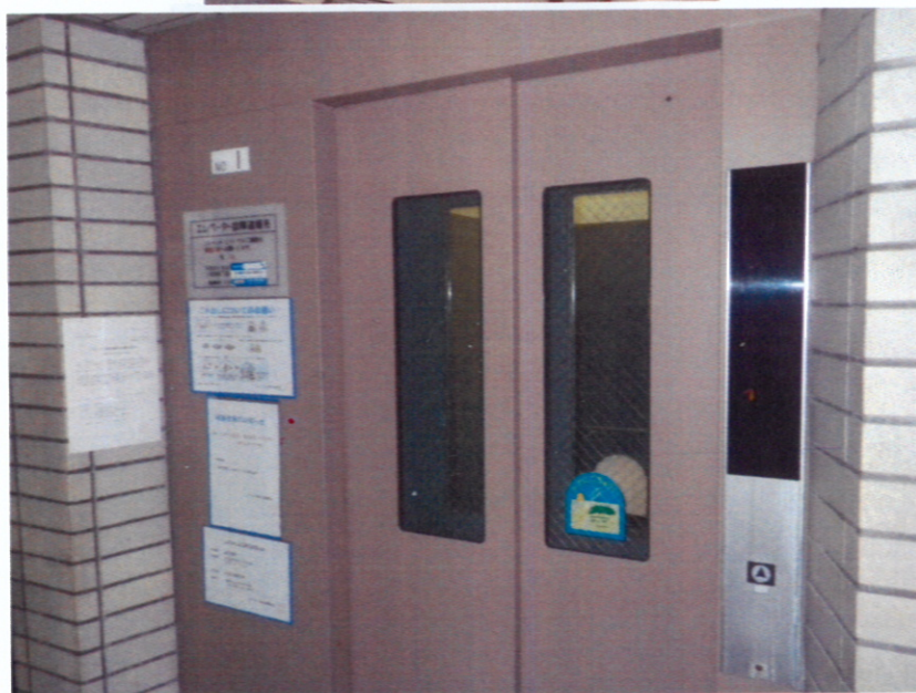
西棟 施工前 1階乗場②
