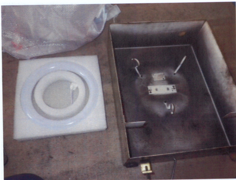
西棟 施工中 かご内照明器 具③
