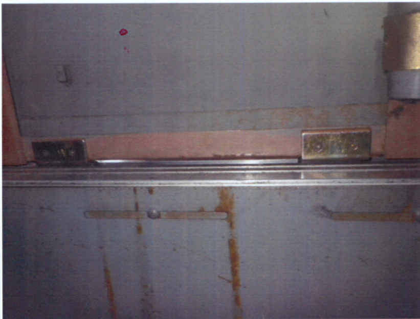
東棟 施工後 新品ドアシュ ー
