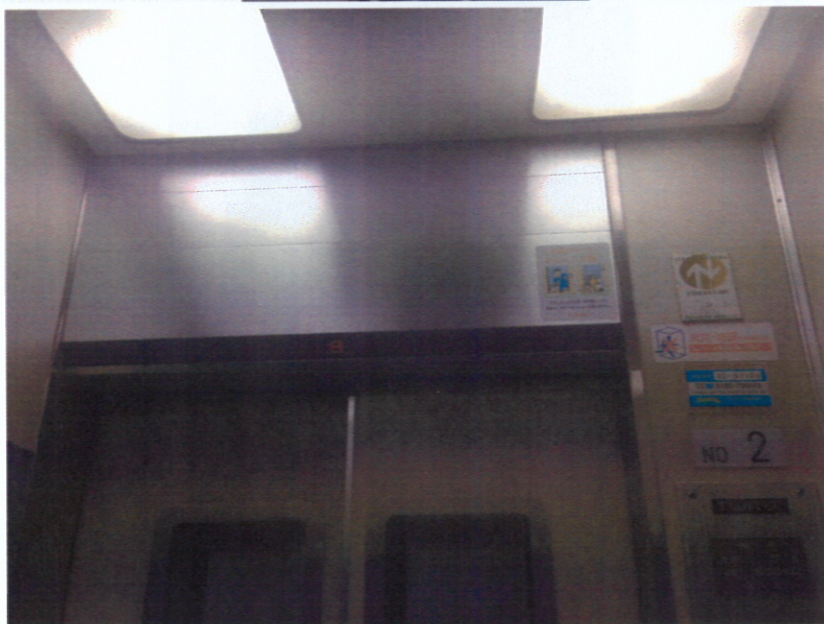
東棟 施工前 かご内幕板
