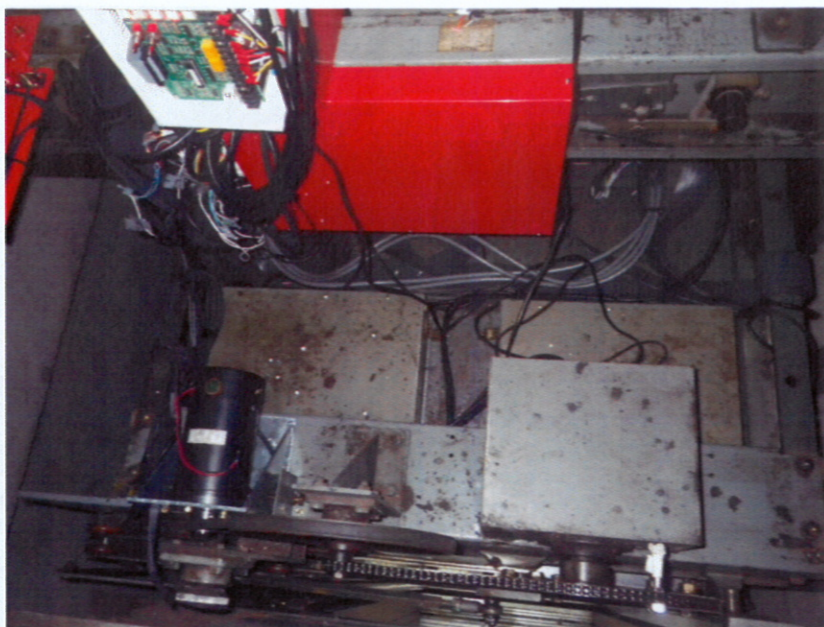
東棟 施工後 かご上ドアモ ーター
