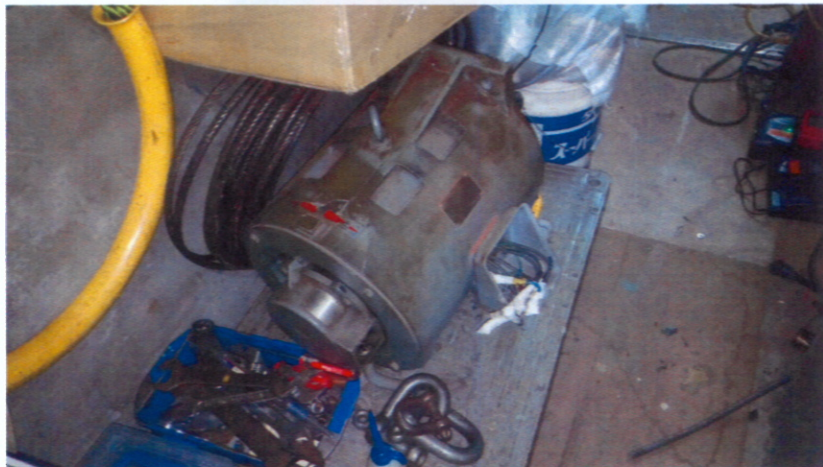
東棟 施工中 巻上機解体③
