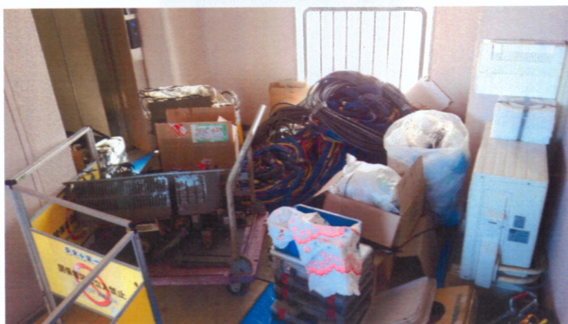
西棟 施工中 撤去品
