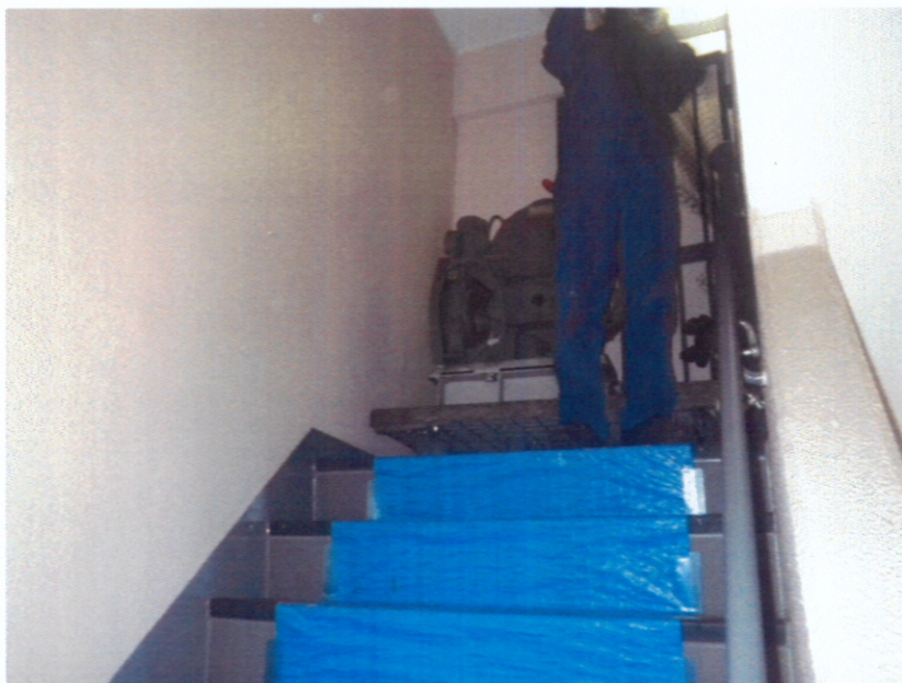
東棟 施工中 部材搬出①
