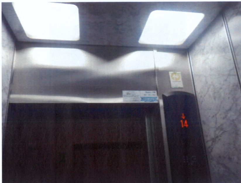
西棟 施工後 かご内幕板
