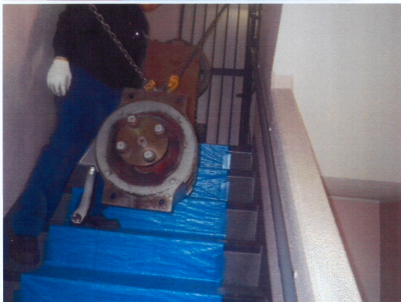
東棟 施工中 部材搬出②
