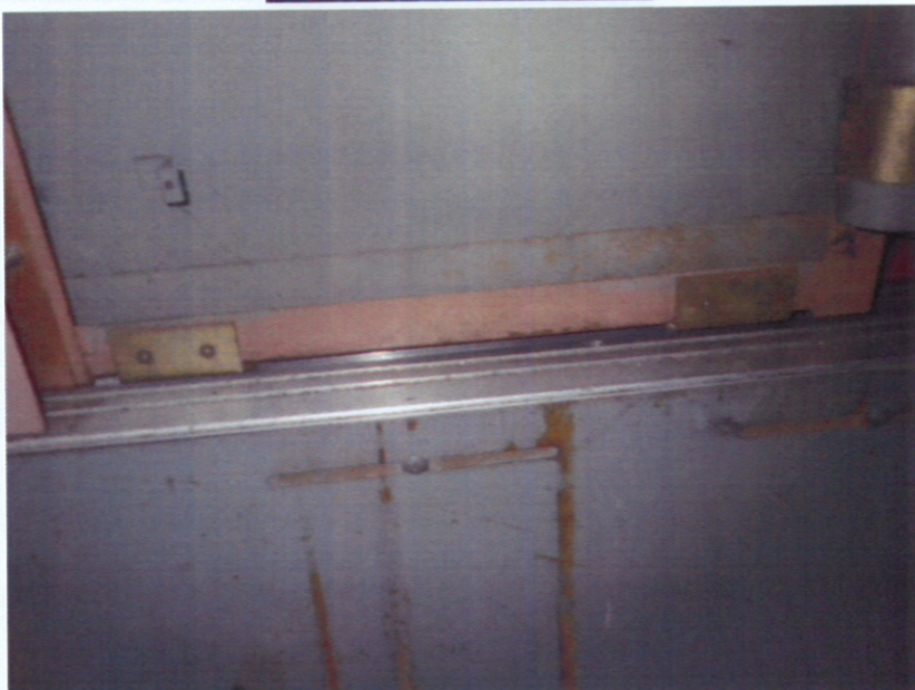
東棟 施工前 各階ドアシュ ー
