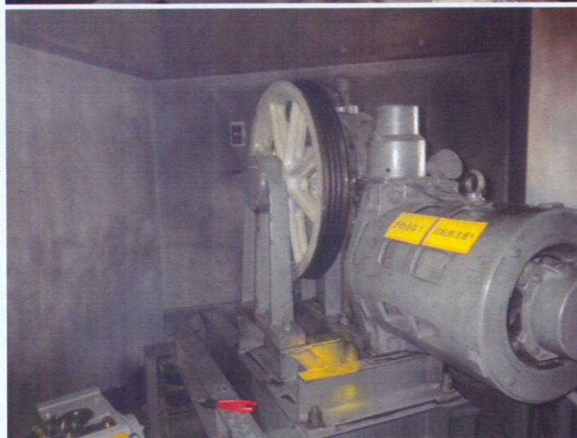
東棟 施工中 主ワイヤーロ ープ取替②
